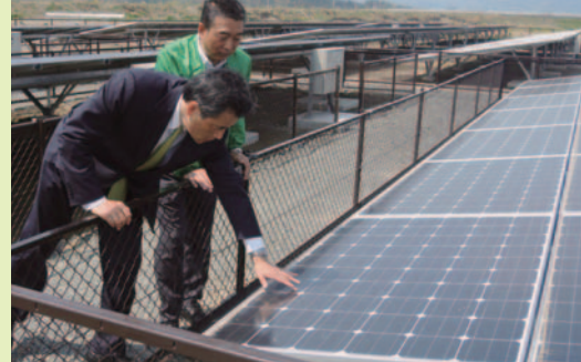
▲ 野菜工場と太陽光発電所が一体となった南相馬ソーラー・アグリパーク
